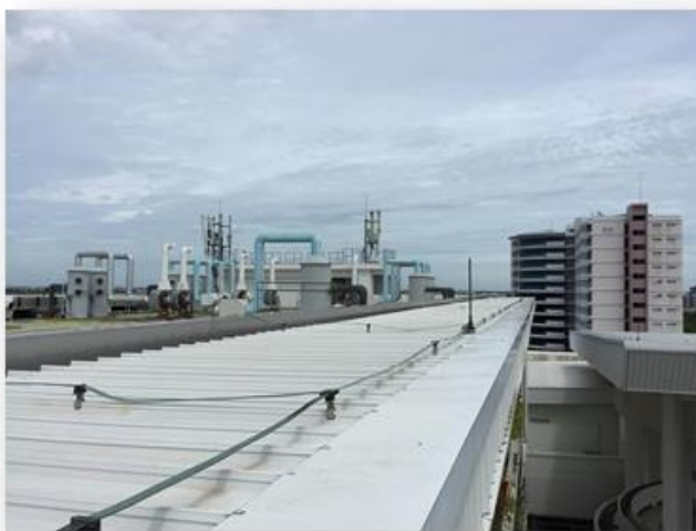
ติดตั้งอุปกรณ์ป้องกันฟ้าผ่า
