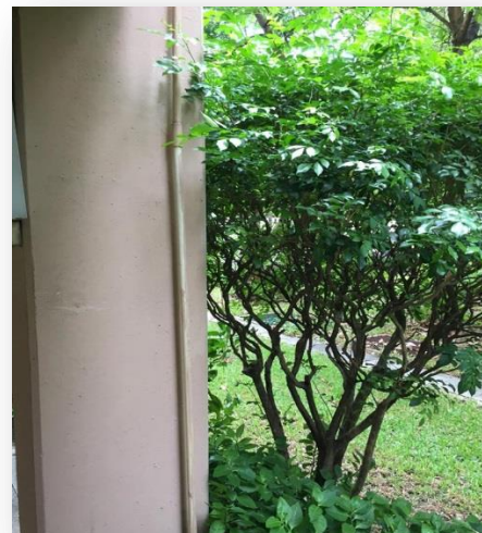
การติดตั้งอุปกรณ์ระบบการป้องกันไฟฟ้าดูดติดตั้งสายดิน
