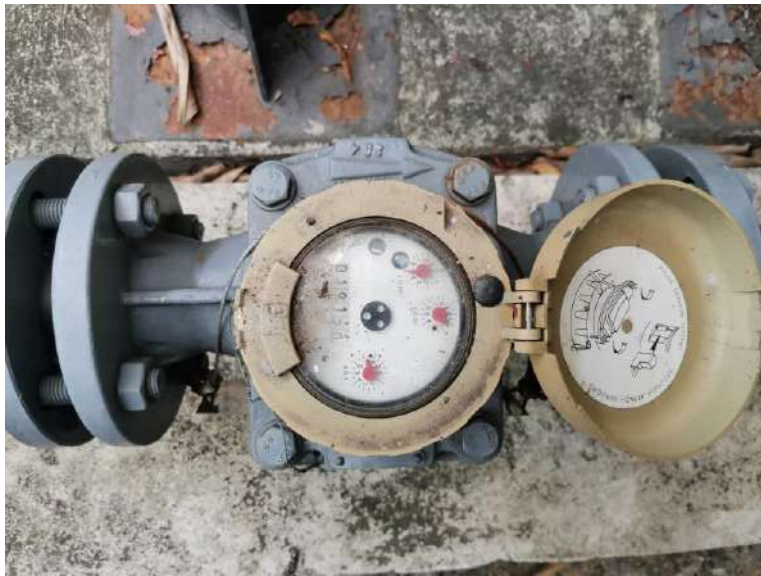
รูปที่ 4 หน้ามาตรบ่งบอกปริมาณการใช้น้ำประปาแบบใบพัด ของแต่ละอาคารย่อย [3]
