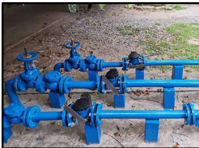
รูปที่ 3 มาตรวัดน้ำประปาดีจิตอลแบบอัลตราโซนิก [3]
