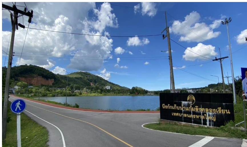
รูปที่ 3 อ่างเก็บน้ำแก้มลิงคลองเรียน
