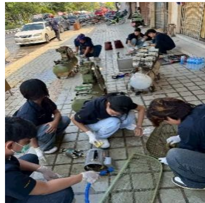
รูปที่ 14 แสดงการถอดล้างทำความสะอาดชุดถังตกตะกอน
