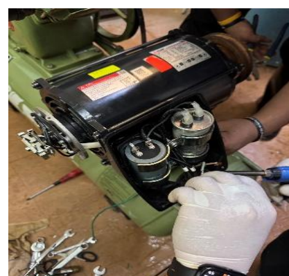
รูปที่ 28 แสดงการประกอบชุดมอเตอร์เข้ากับปั๊มลม
