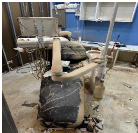
รูปที่ 9 แสดงการตรวจสอบสภาพความเสียหายภายในคลินิก
