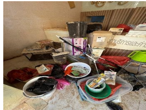
รูปที่ 8 แสดงการตรวจสอบสภาพความเสียหายภายในคลินิก
