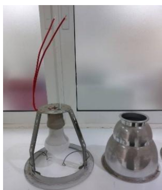
รูปที่ 4 แสดงการปรับปรุงขั้วหลอดจากเดิมเป็นแบบขั้วเสียบ ชนิดเซรามิก แบบเกลียว
