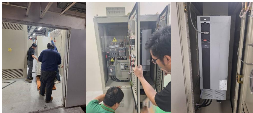
รูปที่ 3 แสดงการติดตั้งชุดควบคุมความเร็วรอบมอเตอร์ (Inverter/VFD)
