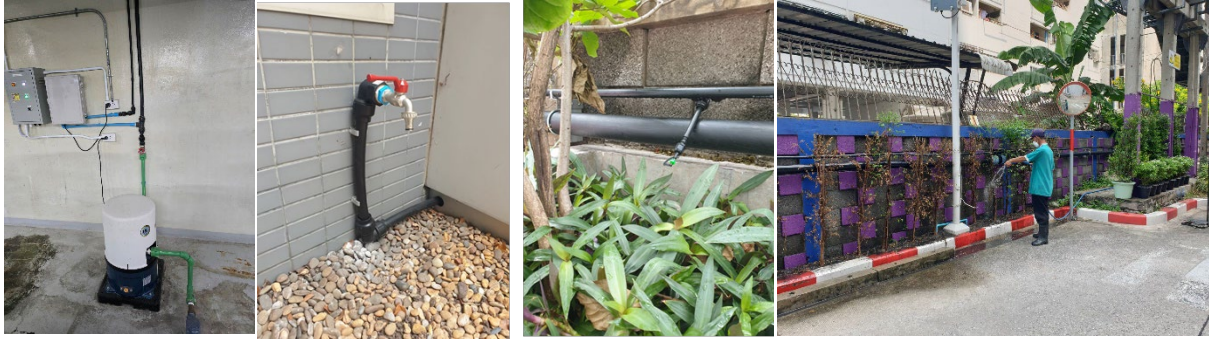
รูปที่ 3 แสดงระบบควบคุมปริมาณน้ำอัตโนมัติ และการนำน้ำไปใช้งาน
